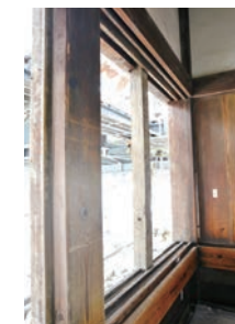
△発見された敷居・鴨居
